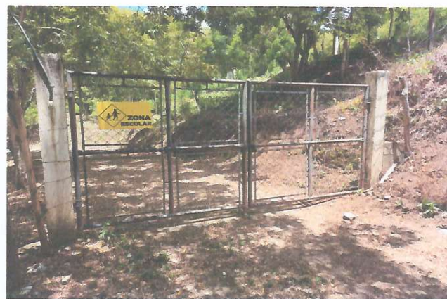
Foto 2: Mejoramiento de pintura de portón
