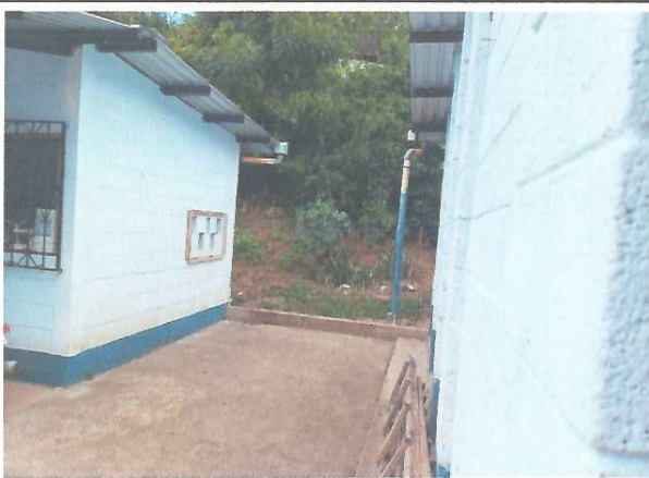
Foto 3: Instalación de lavamanos
