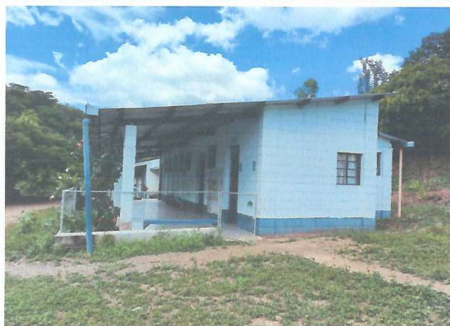
Foto 1: Mejoramiento de pintura general
