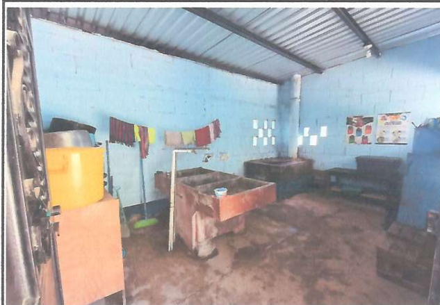
Foto 4: Reparación de polletón, reparación de pila y mejoramiento de piso
